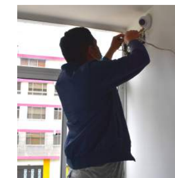
fotografía: Revisión de cámaras del Hotel
