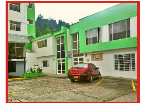
Fotografía: instalaciones oficiales Cotranal Pamplona, Norte de Santander, Marzo 2021.
